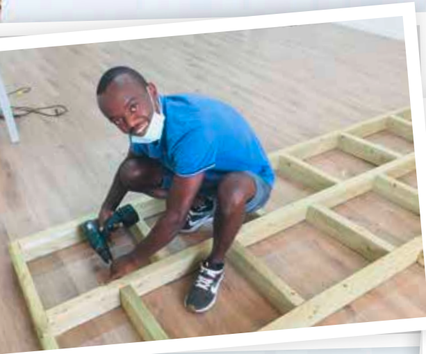
Stefanos baut die Bühne in Beresheets neuem Treffpunkt
