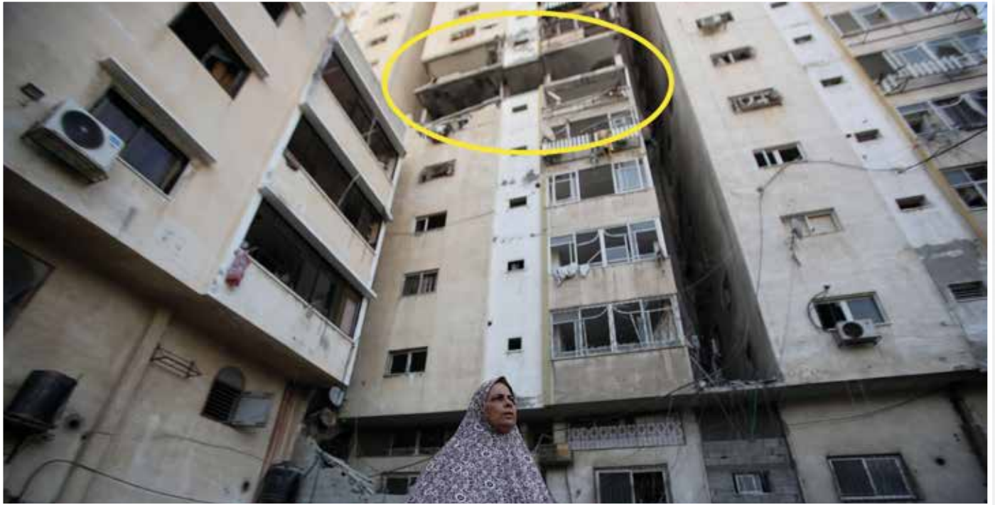
Das Wohnhaus in Gaza, in dem die IDF-Gleitbomben in das Stockwerk über dem Versteck des Kommandanten des Islamischen Dschihad, Tayseer Jabari, einschlugen. Die Explosion brachte die Decke zum Einsturz und tötete Tayseer und 15 weitere anwesende Terroristen.
